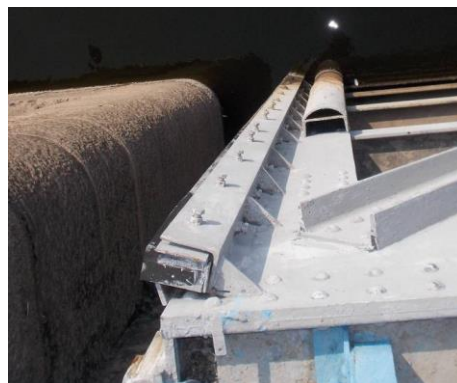
detail srazového těsnění vrat DO
